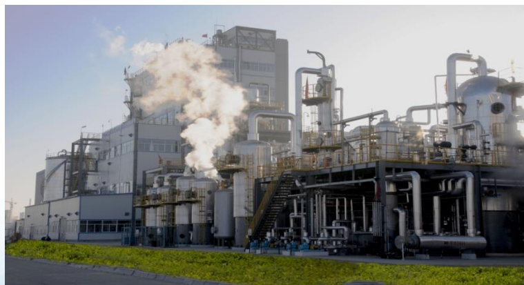
煤化工企业 Coal-Chemical Plants
